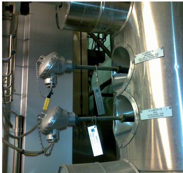
TRA-T30 med form 4 skyddsficka monterad i processen.
